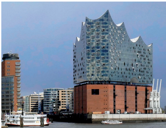
Elbphilharmonie, Hamburg / THERMAX® Brandschutz Deckenkonstruktion
